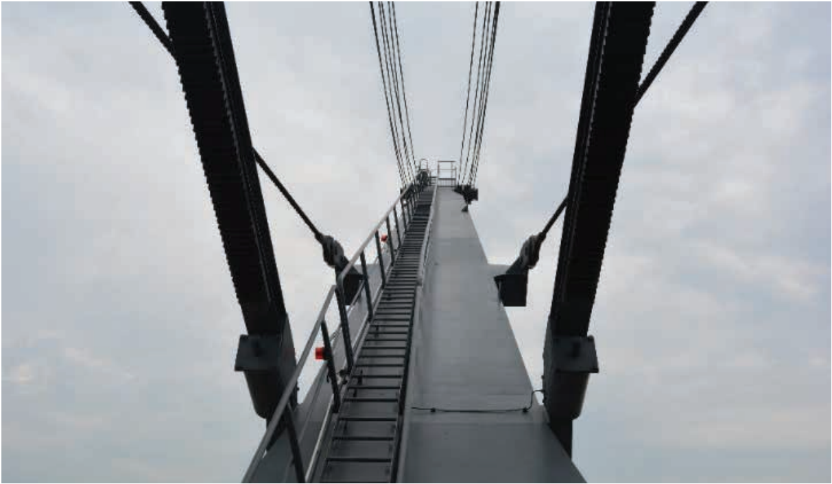
รูปที่ 20 แสดงการตรวจสอบโครงสร้างปั้นจั่น
