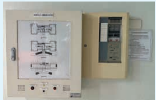
รูปภาพที่ 1 แสดง ตู้ควบคุมระบบแจ้งเตือนเหตุเพลิงไหม้ และวงจรไฟฟ้าของ อาคาร บก.อรม.อ.
