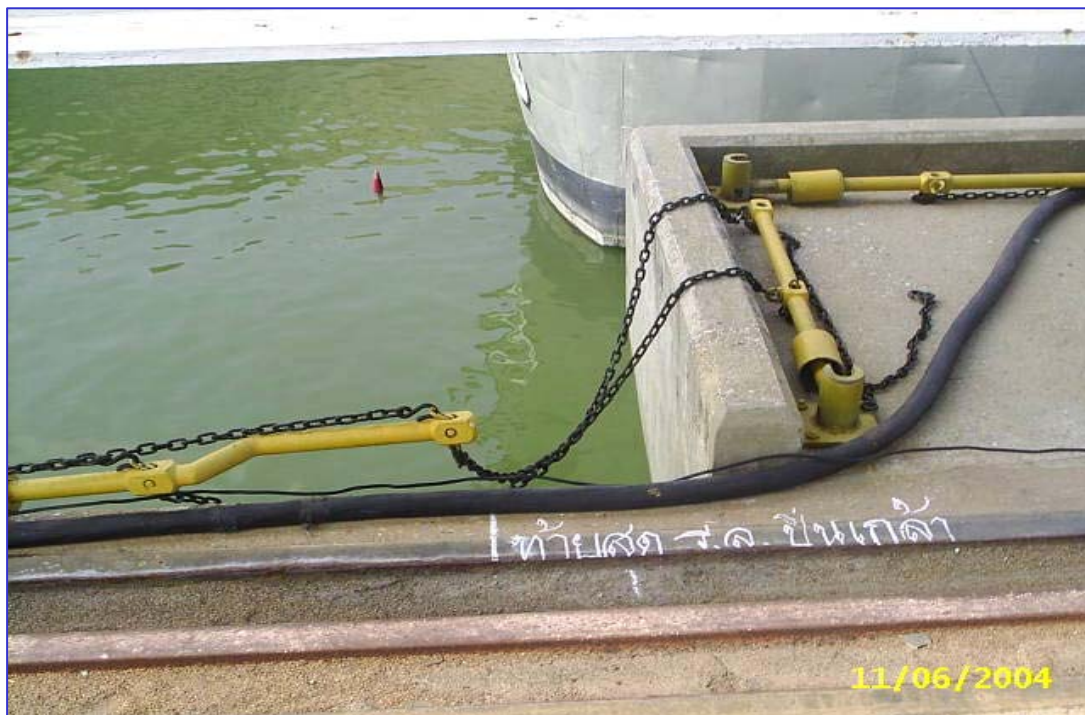
การทำเครื่องหมายท้ายเรือสุดที่ข้างอู่ทั้งสองข้าง
