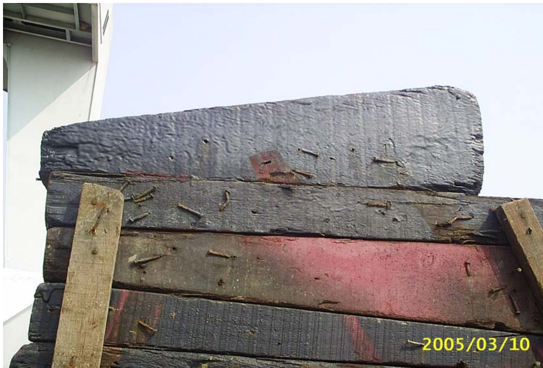
ไม้หมอนลิ่มที่ใช้เป็นหมอนตัวบนสุดของหมอนข้าง
