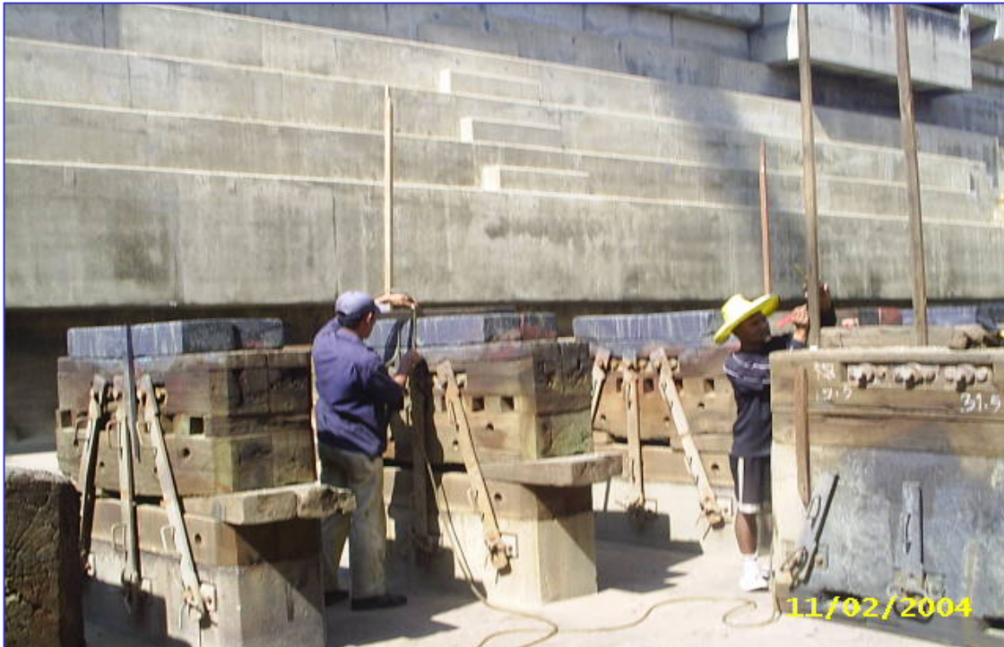
การถ่ายระดับหมอนกลางไปหมอนข้างด้วยสายยางระดับน้ำ
