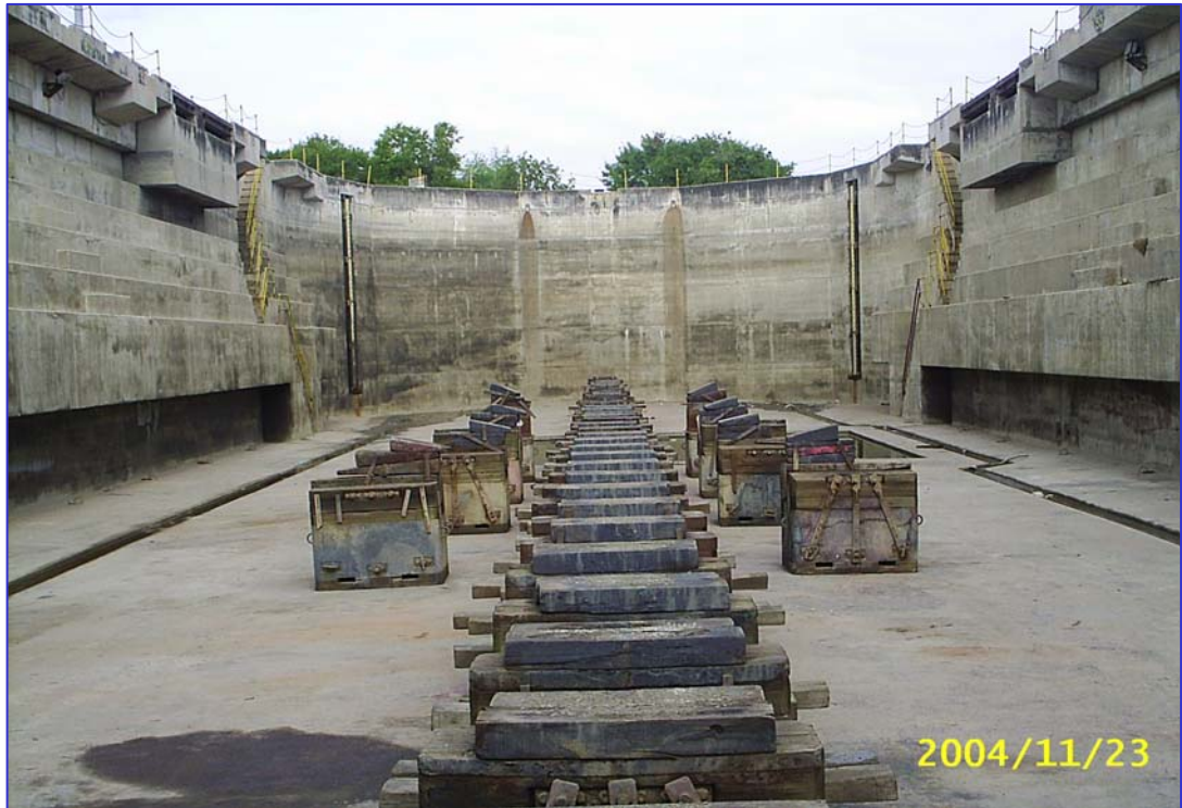
การปรับระดับหมอนแบบเรื่อนั่งหมอน
