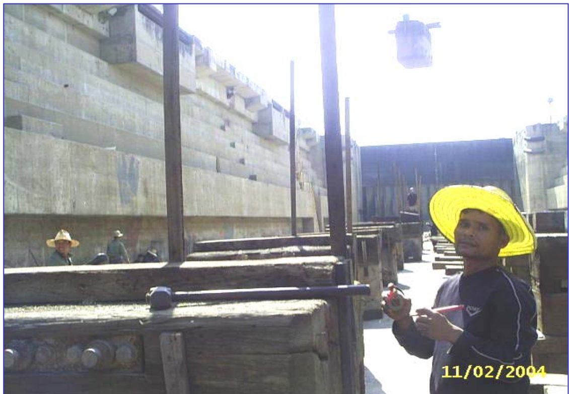
การตีไม้ประทับหมอนเพื่อชิงเชือกเส้น BASE LINE
