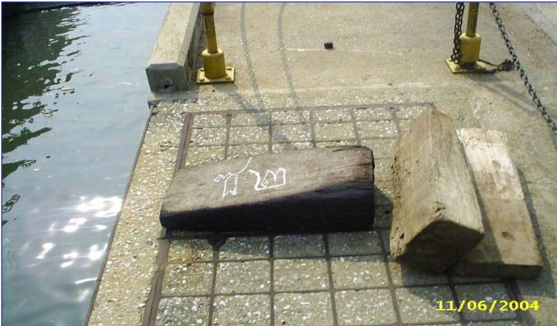
การชักไม้หมอนลิ้มของหมอนข้างตัวบนออกมาวางที่ข้างอู่
